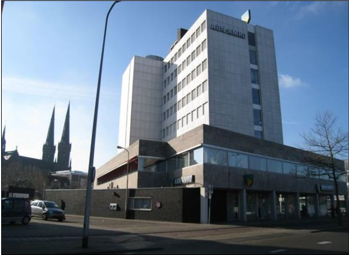
Door Bedaux ontworpen bankgebouw aan de Spoorlaan in Tilburg, 1975. De gevels zijn met tresa bekleed (josbedaux.nl).
